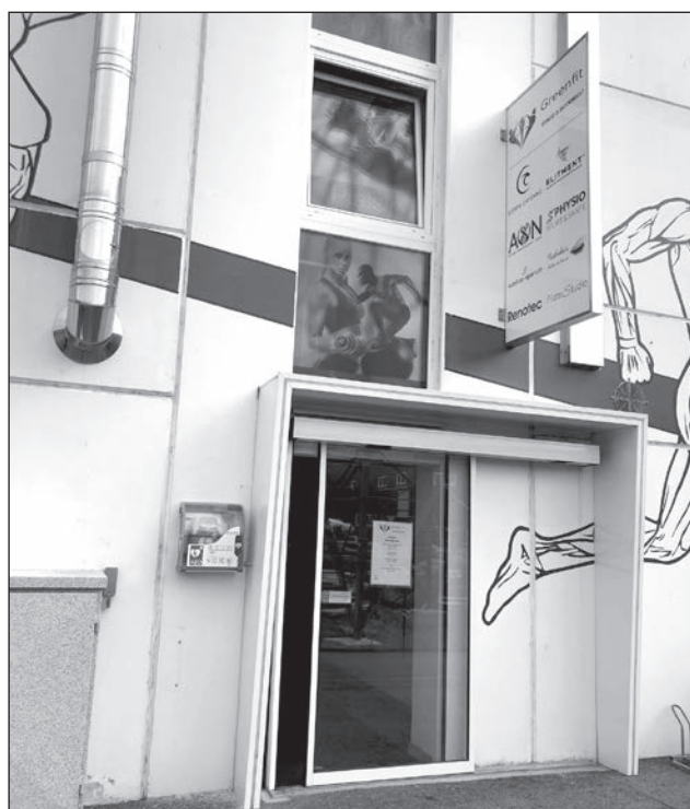
Standort Defi Greenfit
